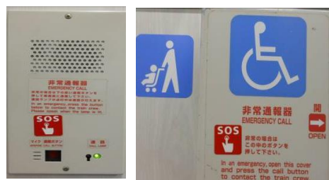
〈非常警報装置〉
