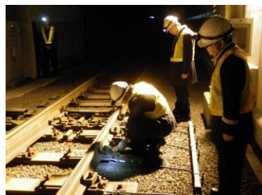
〈駅係員の転てつ器鎖錠訓練〉
