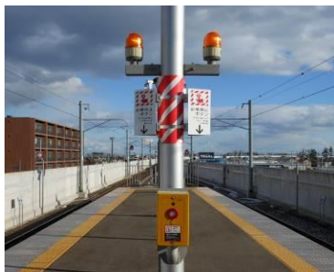
〈列車非常停止警報装置〉
